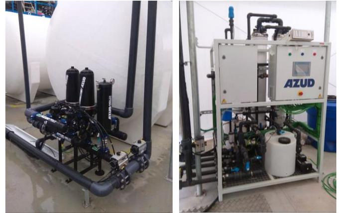
**Figs. 12 & 13:** Microfiltración (izquierda) y Ultrafiltración (derecha) de Water2REturn
