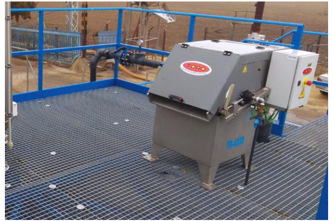
Fig. 8: Unidad de separación de sólidos (tamiz rotativo) de Water2REturn
