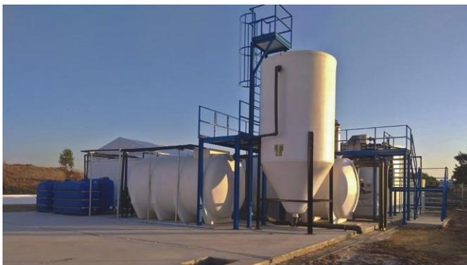
**Fig. 12:** Espesador de Water2REturn
